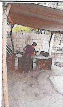
Foto 3: Remozamiento de cocina, ya que se encuentra en mal estado, siendo necesario contar con un espacio adecuado para la preparación de los alimentos de forma segura.
