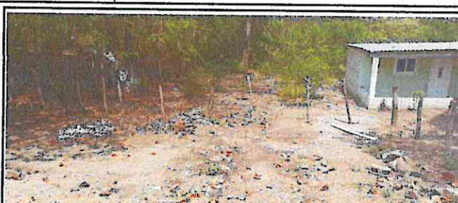
Foto 2: Circulación en mal estado, poniendo en riesgo la seguridad de los estudiantes, ya que cualquier persona o animal puede ingresar fácilmente al centro educativo.
